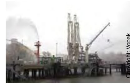
Die neue Vopak-Löschbrücke in Hamburg ist auch für LNG-Betankung geeignet
