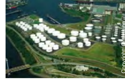
Das Oiltanking Tanklager
