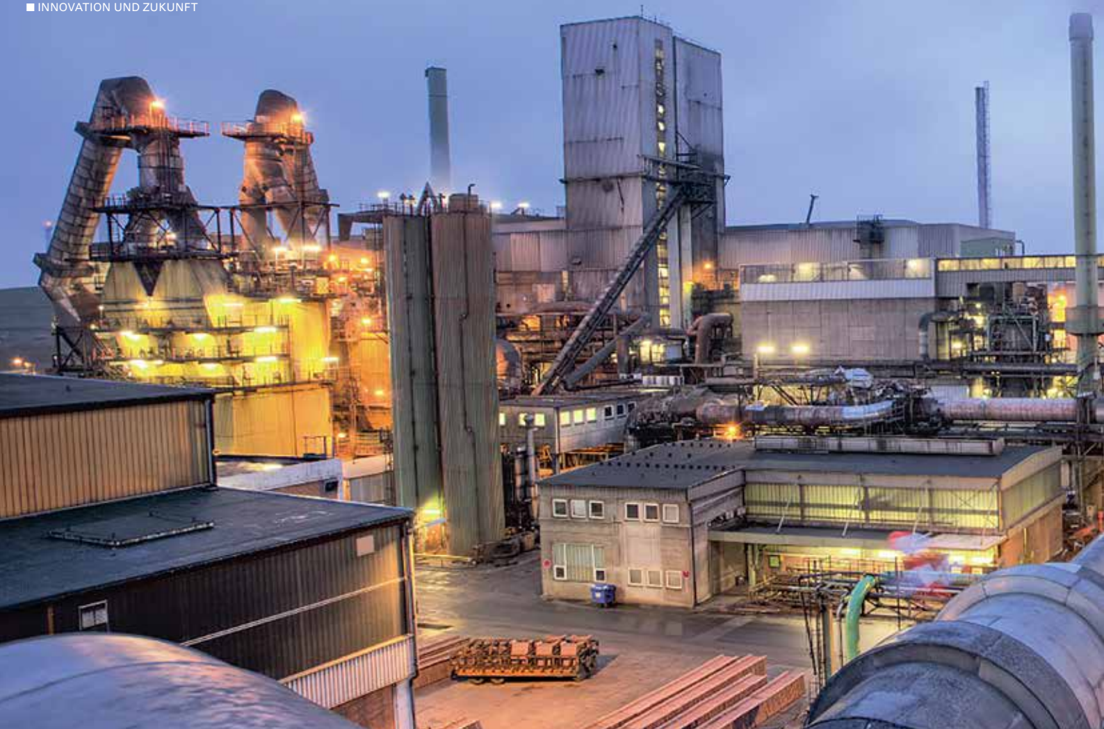
Aurubis entnimmt die Wärme aus der sogenannten Kontaktanlage, in der das im Prozess anfallende, gasförmige Schwefeldioxid in flüssige Schwefelsäure umgewandelt wird. Sie besteht aus insgesamt drei Strängen. Aus jedem einzelnen können jährlich etwa 160 Mio. Kilowattstunden (kWh) Wärme ausgekoppelt werden.
