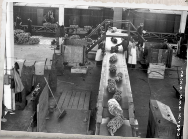
Bananenstauden werden auf einem Förderband vom Lager zur Laderampe transportiert, wo sie in einen Güterzug verladen werden. Parallel wird die Qualität der Ware geprüft
