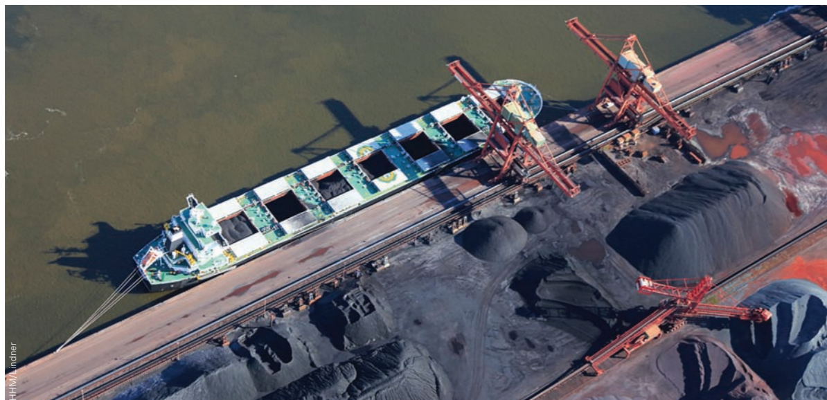
Hier am HANSAPORT werden die Erze für die Salzgitter Flachstahl AG per Seeschiff angeliefert.
