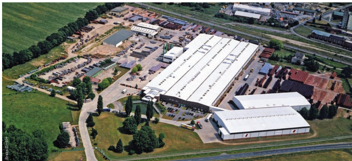
Das Werk der Braas GmbH für die Produktion von Dachziegeln liegt in Karstädt bei Brandenburg.
