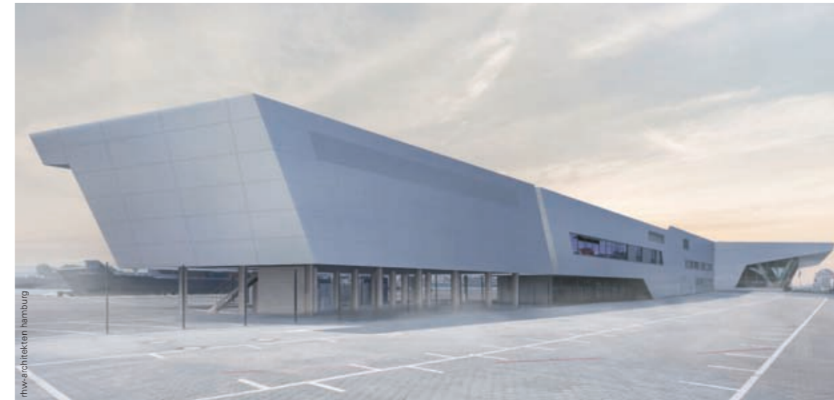
Unten: Am Hamburg Cruise Center Altona wird die erste Landstromanlage für Kreuzfahrtschiffe installiert.
