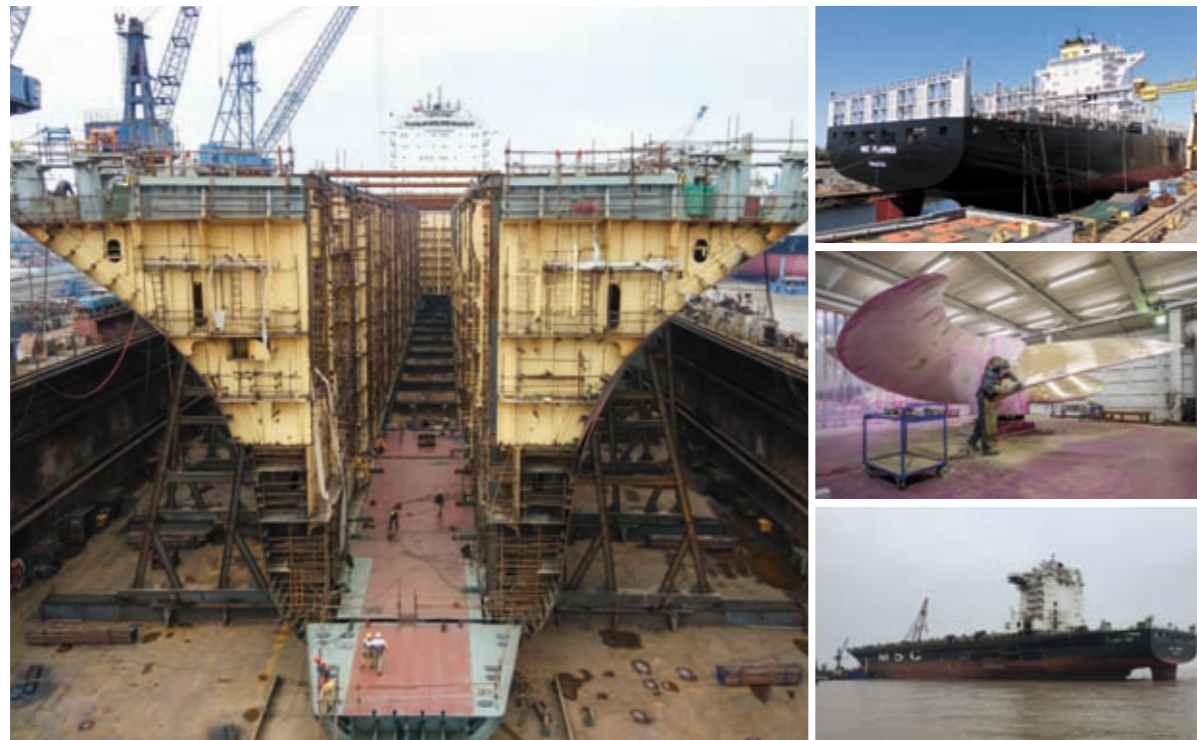
Neue Bugwulste, energie-effizientere Propeller, Anpassungen an der Hauptmaschine oder eine Erhöhung der Ladekapazität – eine Optimierung von Bestandsschiffen ist deutlich effizienter als ein Neubau.
